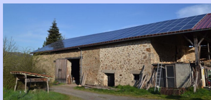
Centrale de Vaudet / SAS La Citoyenne Solaire
